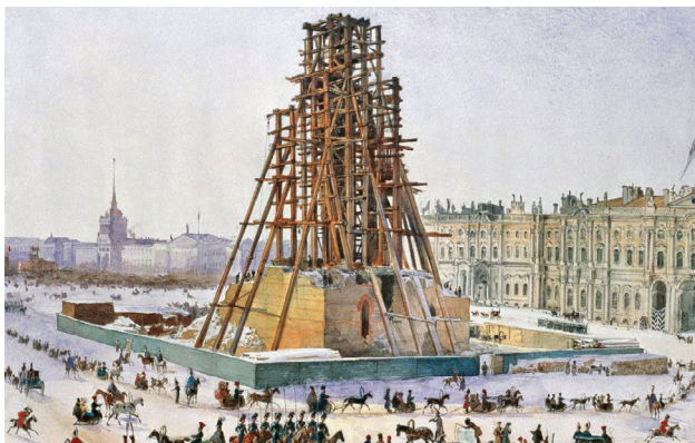
Figura 15. Mecanismos de izado de la Columna-monolito del zar Alejandro I (frente al Palacio de Invierno).
