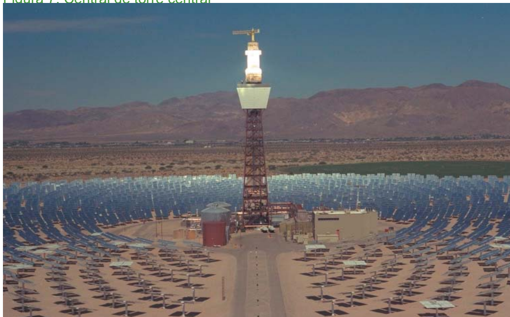
Figura 7. Central de torre central
