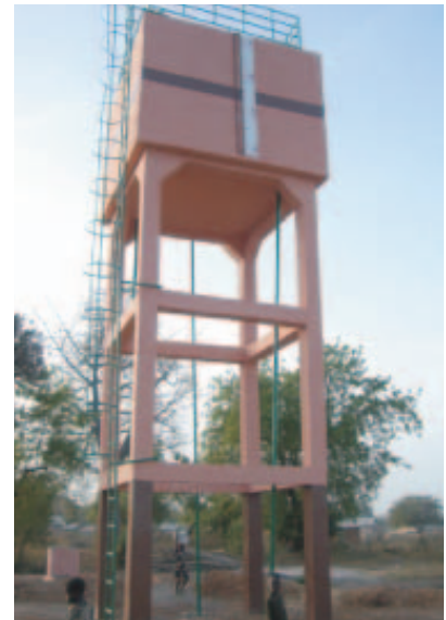
Depósito de agua.
