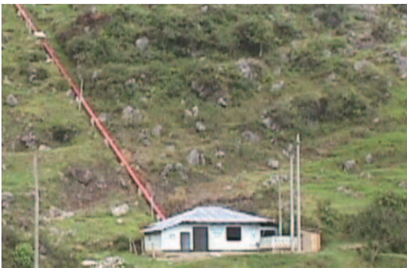
Ejemplo de una central microhidráulica de derivación.
